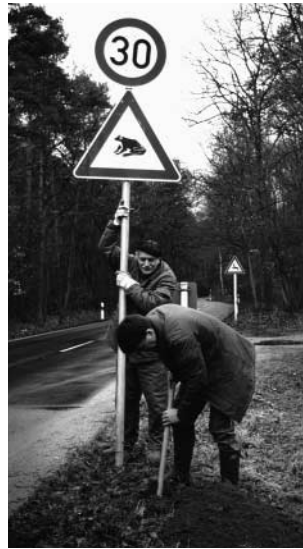
◀ Amphibienschutz: Aufbau einer Amphibienleiteinrichtung, Errichtung von Warnschildern
